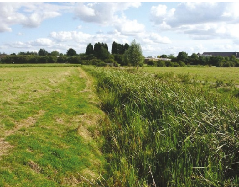
Obr. 20: Vegetačná priekopa na zachytávanie drenážneho výtoku
